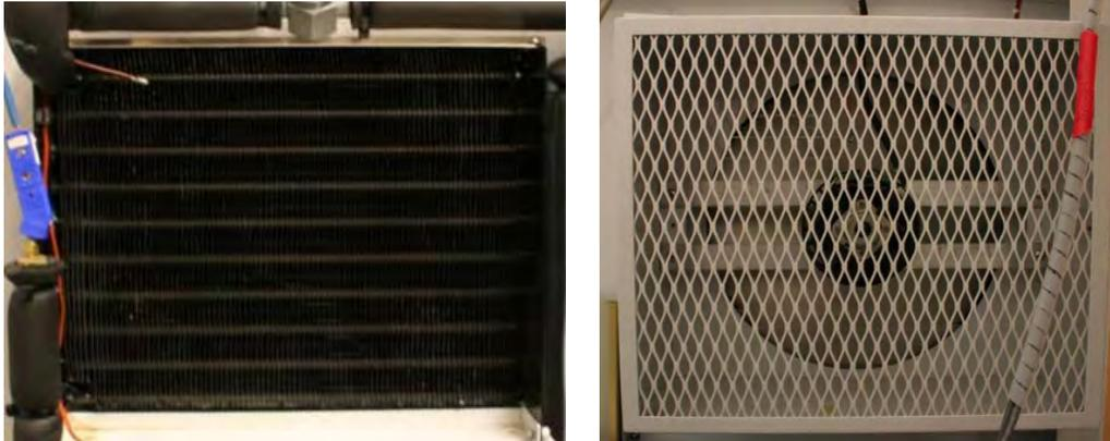
**Figure 2.7 The condenser fan unit**
